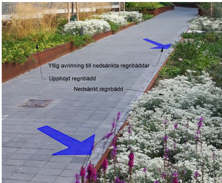
Figur 18 Illustration över en kombination av upphöjda respektive nedsänkta regnbäddar med ytlig avrinning från hårdgjord mark till nedsänkta grönytor
