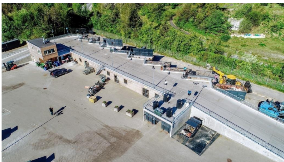
Exempel på ramp byggd i moduler. Utrymmet under rampen kan användas för förvaring m.m. Foto: från Modulo Systems
