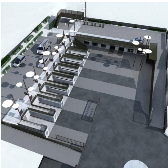
Nacka kretsloppspark i Älta är ett exempel på ramp byggd i moduler där utrymmet under rampen utnyttjas för förvaring, men även en studio som kan användas för utbildning m.m. Foto: Modulo Systems.
