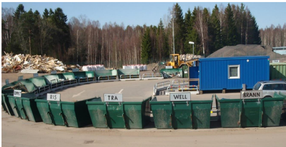
Exempel på återvinningscentral utan ramp. Mindre containrar med så kallade BM-fästen används. Tung trafik och persontrafik separeras. Foto: Gunnar Weiring
